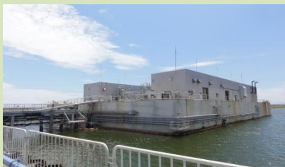
埋立等によって生じた余水を排水処理施設で処理し海域の水質汚濁を防止
