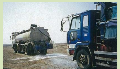
場内散水により粉じんの発生を防止
